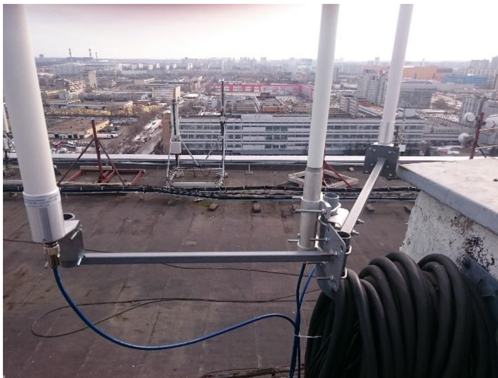
Рис. 3 Пример корректного крепления антенны
